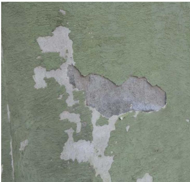
ne sempre superficiale, normalmente si crea un sottile alone d'umidità attorno alla cavillatura. I materiali interessati a questa patologia di degrado sono gli intonaci, gli stucchi e i materiali ceramici.
